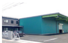
⑨大分工場 大分県中津市大字田尻崎 20番地4
