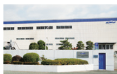
⑧鶴浜工場 山口県防府市浜方 287-14
